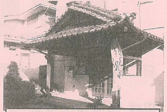
こちらが会館前の様子です 井土ヶ谷上町第一町内会館
