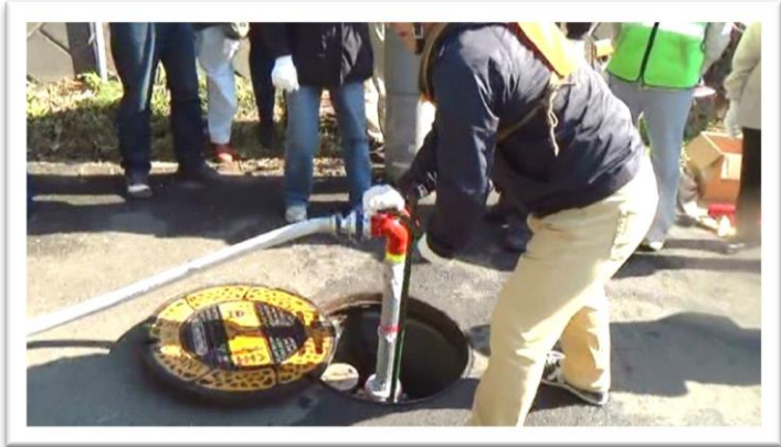
マンホールを開けて、消火栓のバルブにホースをつないでいるところ。
